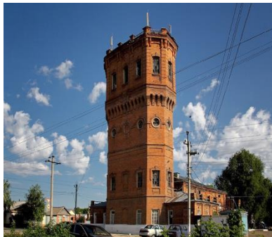
Водонапорная башня «Водосвет»
